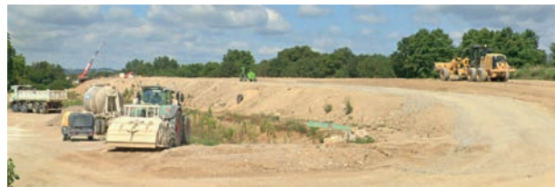
Chantier de l'A69 à Castres ©Google Maps
